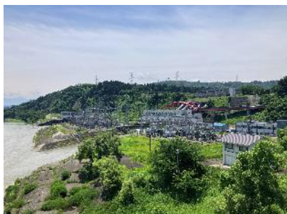
図 1-31 小千谷発電所 未指定文化財（建造物） 山辺 現代
