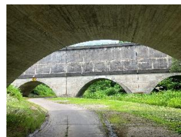
図 7-9 真人沢水路橋 未指定文化財（建造物） 真人 現代
