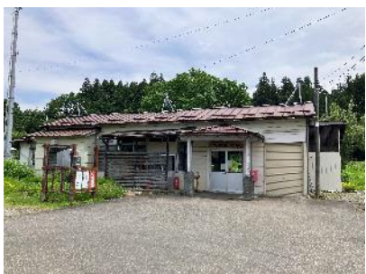
図 7-4 越後岩澤駅 未指定文化財（建造物） 岩沢 近代
