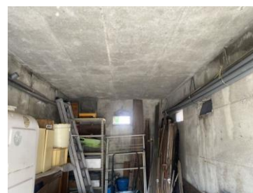
別棟車庫内部
