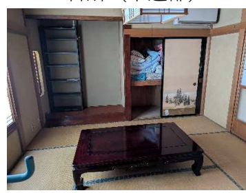
1階和室 (鉄骨部)
