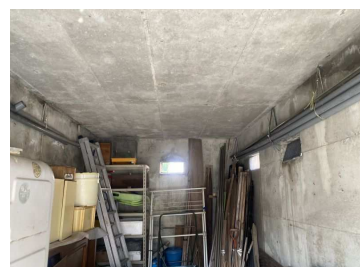
別棟車庫内部
