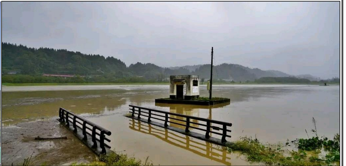
2019.10.12 撮影 台風19号水害 逆流で湛水の下夕島地内
