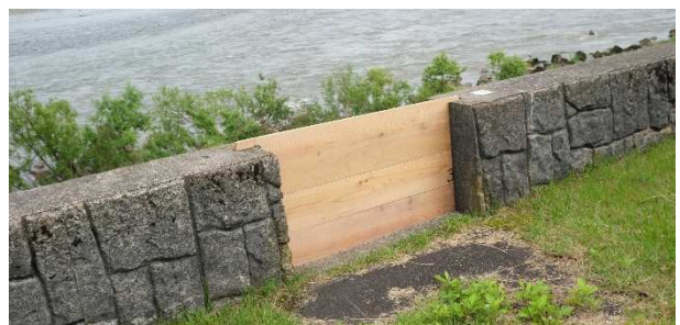
柵板設置状況
