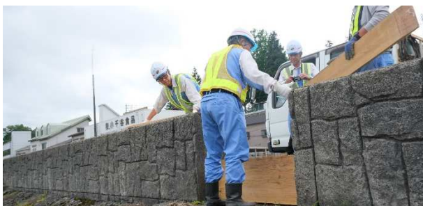
柵板設置訓練
