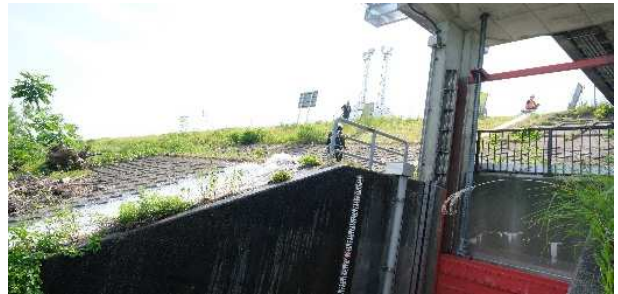
排水ポンプ排水状況
