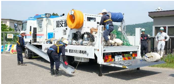
排水ポンプの設置訓練
